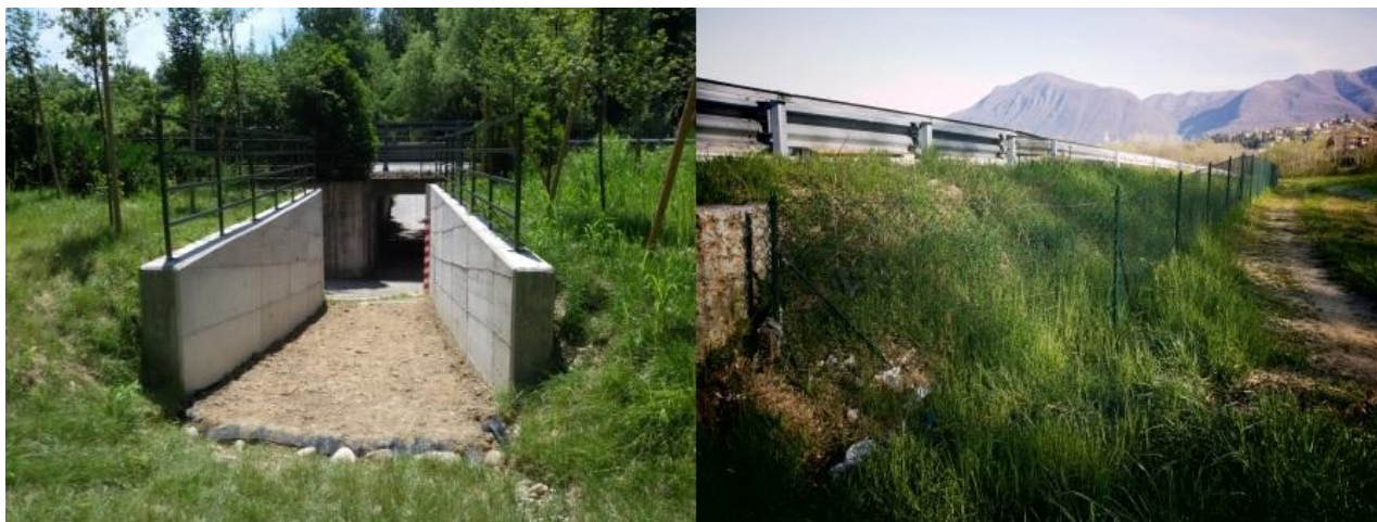
Figura 3 – Opere di deframmentazione e di indirizzo dei flussi faunistici presso i varchi V37 Cazzago Brabbia (a sinistra) e V49 Cocquio-Trevisago (a destra).
